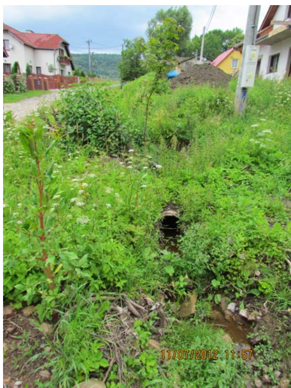
Fot. 4 – istniejący przepust pod zjazdem
